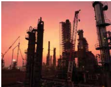
Attività di manutenzione alla raffineria SARPOM
